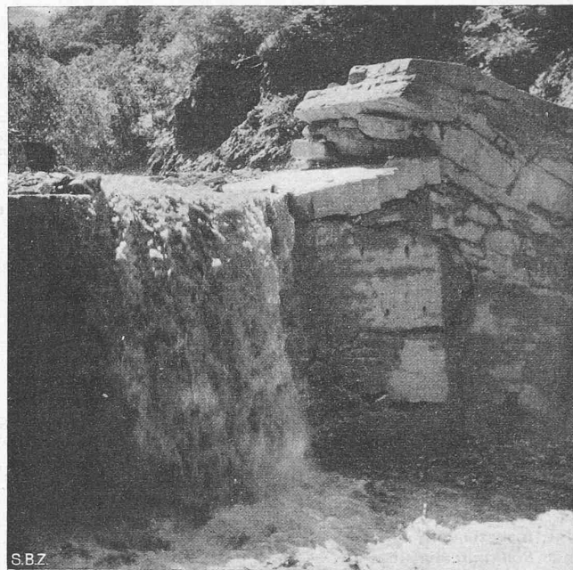
Abb. 1. Nolla-Sperre III unter Einwirkung des Bergdruckes von rechts, Aufnahme 1939 Bew. 31. X. 41 lt. BRB 3. X. 39
