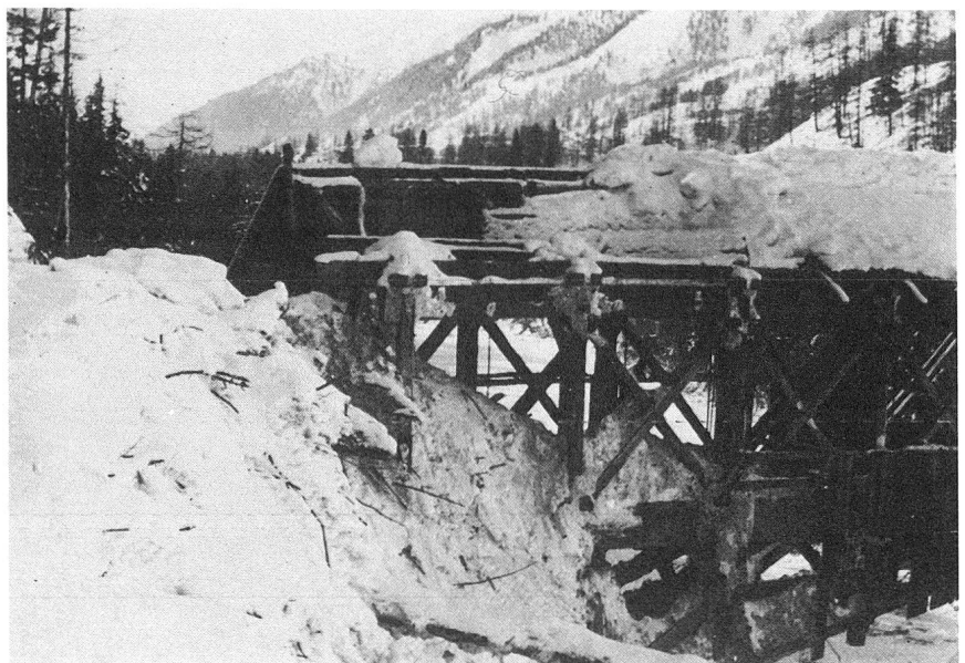
Ende Januar 1951 beschädigte die «Urezza»-Lawine die «Punt Nova», eine alte Holzbrücke bei Zernez. Foto Forstinspektorat GR, Chur
