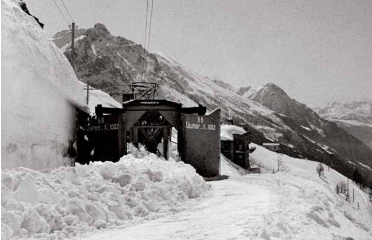
Der Räumerzug mit der «Erfindung» aus Poschiavo erreicht Alp Grüm. Die nachfolgende Schleuder wirft den Schnee aus den Geleisen. Die Galerien zur Sicherung des Palühanges werden erst 1949 und 1952 erstellt.
