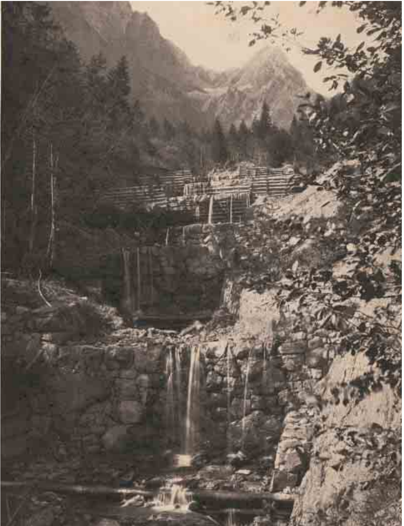
Abb. 167 Sperren am Steinibach bei Hergiswil um 1880.
