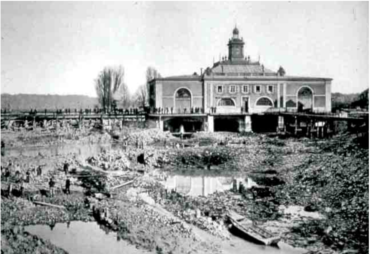
Abb. 194 Bauarbeiten am rechten Rhonearm Anfang 1887. Blick flussaufwärts. Sohvertiefung. Erstellung des Regulierwehrs (links). Stilllegung des Rhonepumpwerks mit den 1862–1872 angebrachten Flügeln.
