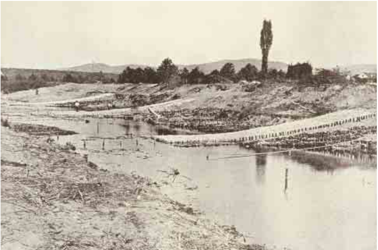
Abb. 168 «Anfang des Gürtelbaues» nach Schindler im Wannenprofil der Versuchsstrecke an der Wiese, 1897.
