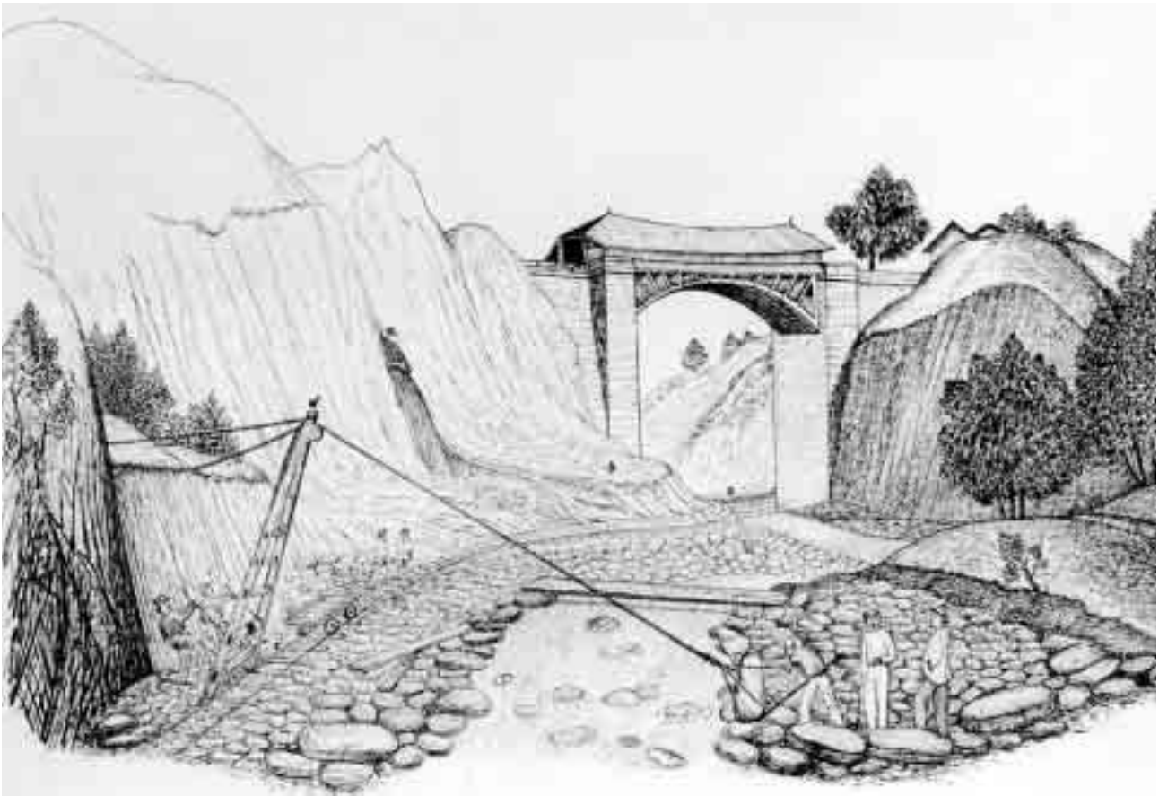
Abb. 99 Einsatz eines «Krahnen, genannt Chèvre» zum Verladen von Blöcken auf eine Rollbahn an der Saltina oberhalb der Napoleonsbrücke. Aus dem handschriftlichen Bericht über die «eidgenössische Inspektion der Rhonearbeiten» von L. Blotnitzki, 1867.
