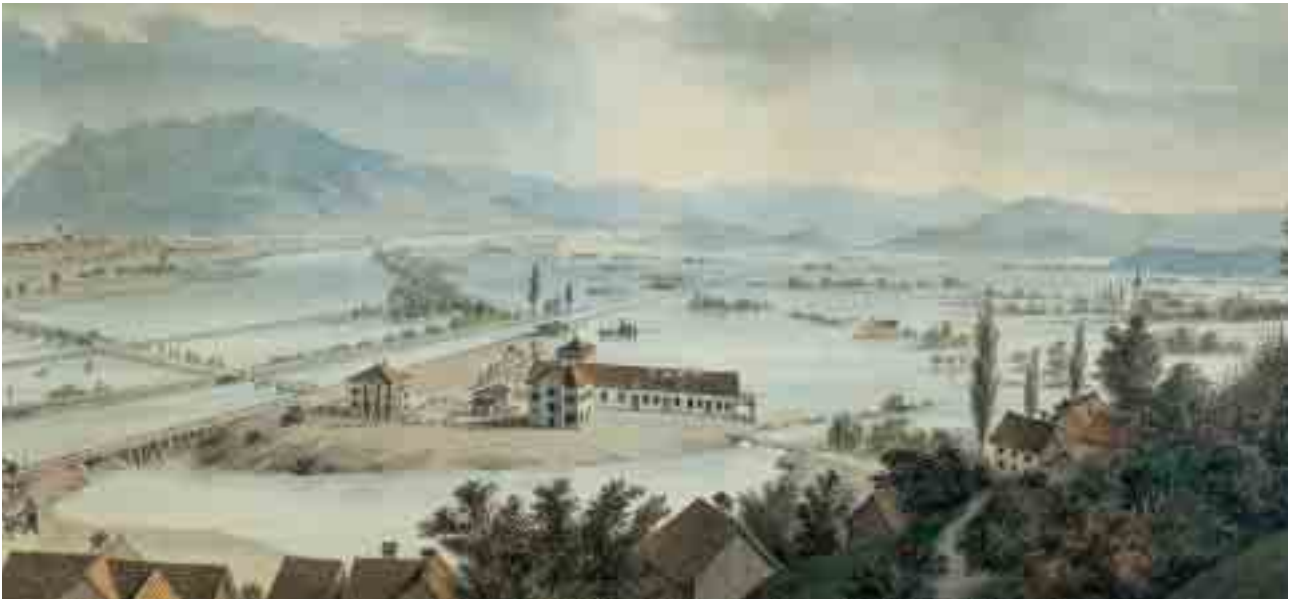
Abb. 92 Rheinausbruch auf der Schweizer Seite, 1868. Blick talaufwärts auf die Bahnstation Au und die dortigen Industriebauten.
