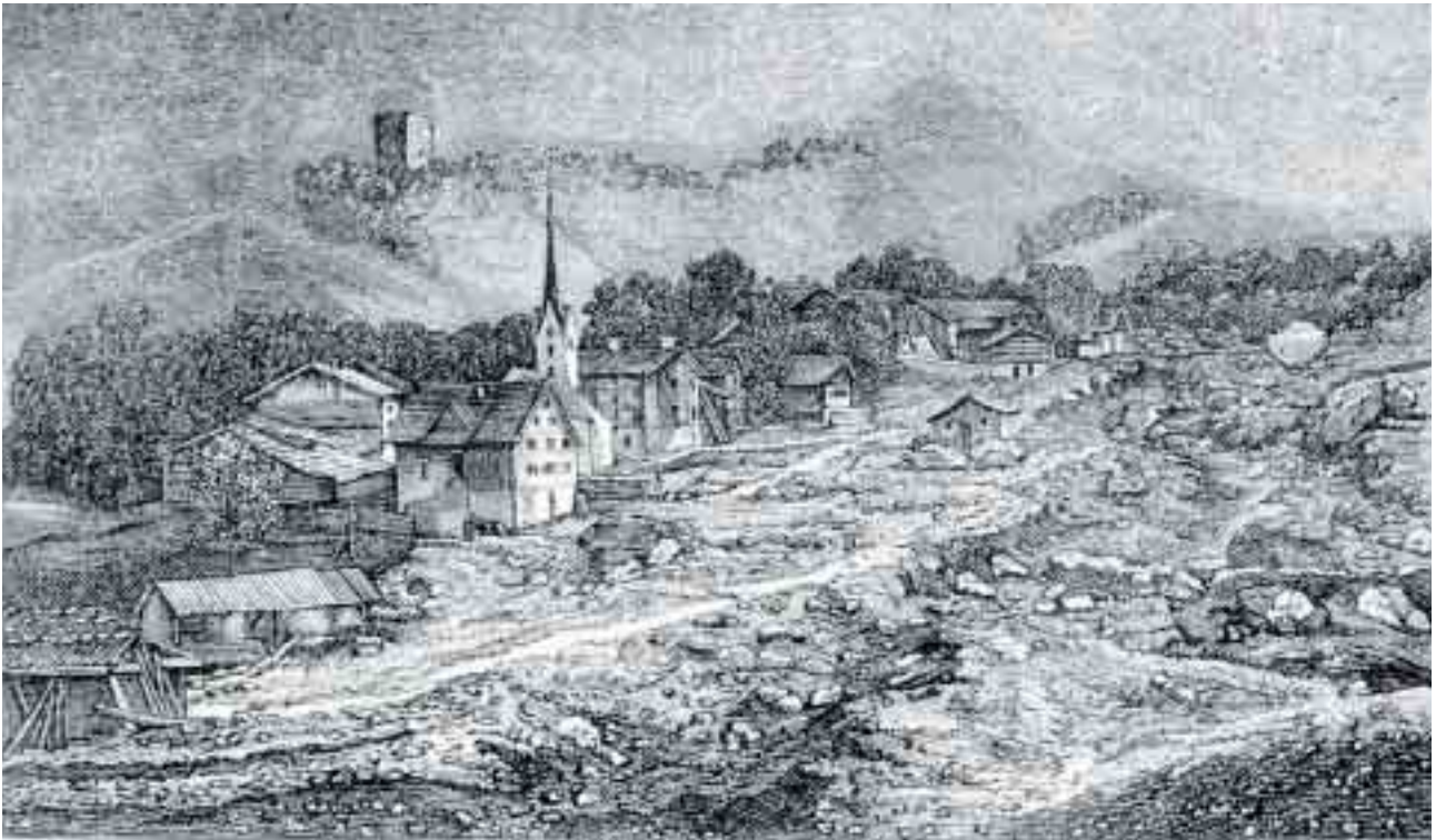
Abb. 163 Die aussergewöhnlichen Hochwasserereignisse 1868. «Verrüfung in Rinkenberg» (Zignau) durch die Zavragia im Vorderrheintal. Blick bachaufwärts.
