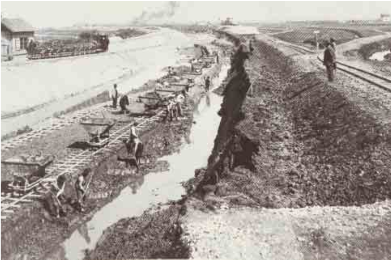
Abb. 47 Trotz einer gewissen Mechanisierung noch viel Handarbeit. Bau des Fussacher Durchstichs 1895–1900.
