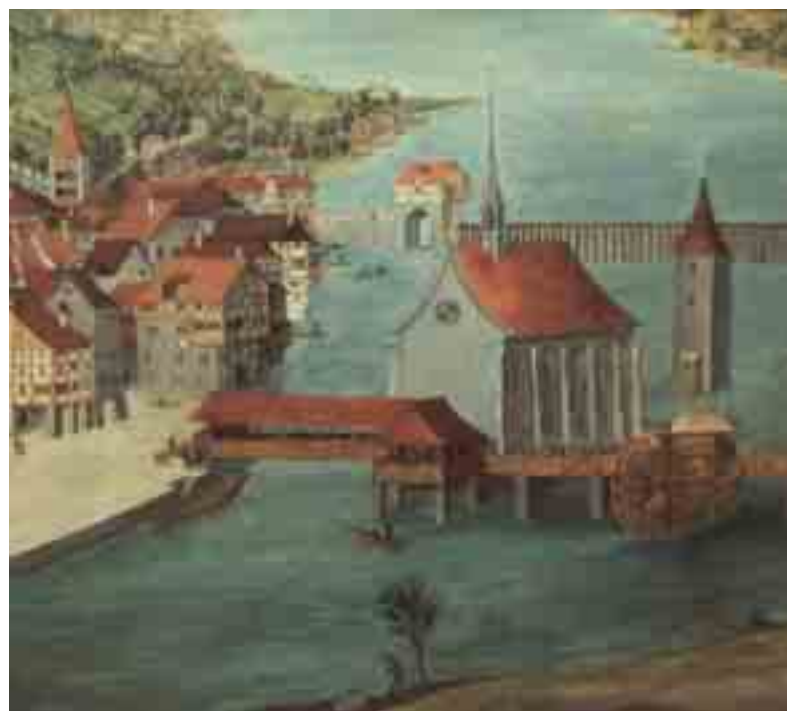
Abb. 183 Der Ausfluss aus dem Zürichsee mit den Palisaden, dem Grendelgebäude, dem Wellenberg, der Wasserkirche und dem oberen Schöpfwerk. Von Hans Leu d. A. um 1502, Blick limmataufwärts.
