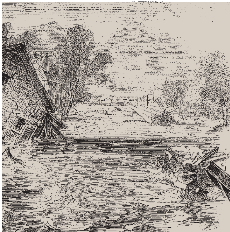
Abb. 200 Die Hochwasser von 1868 betrafen einen grossen Teil der Schweiz und beeinflussten die eidgenössische und kantonale Politik des Hochwasserschutzes entscheidend. Das Bild aus dem Rheintal zeigt neben Gebäudeschäden in Burgerau bei Buchs auch die Unterbrechung der 1858 gebauten Bahnlinie und der Telegrafenerleitung.
