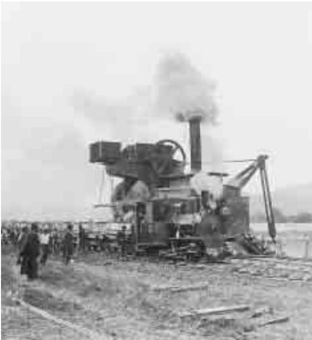
Abb. 95 Bau des Fussacher Durchstichs um 1898. Aushub mit Eimerketten-Trockenbagger, Transporte mit Baubahn der Spurweite 75 cm.
