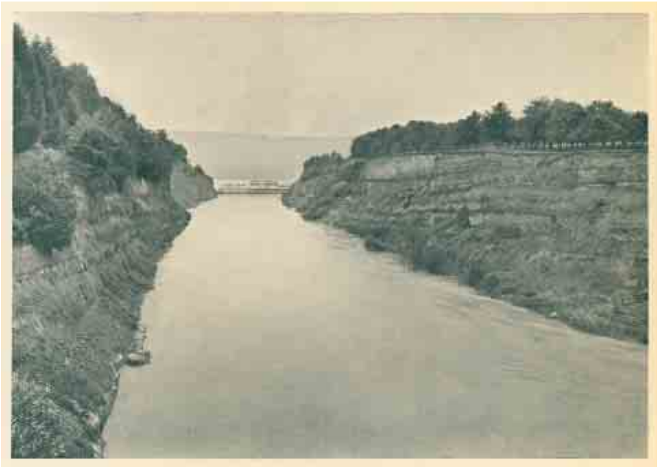
Abb. 104 Hagneckdurchstich um 1900 in Fließrichtung gesehen. Im Hintergrund das Wehr des 1897–1900 am Bielerseeufer erstellten Kraftwerks Hagneck.
