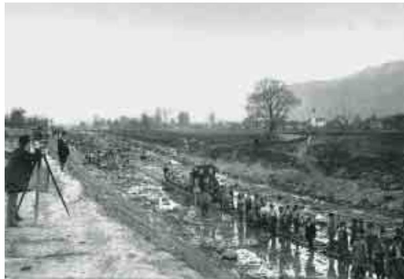
Abb. 93 Bau des Werdenberger Binnenkanals bei Salez um 1882. Aushub und Ufersicherung von Hand, Transporte mit Baubahn der Spurweite 50 cm.
