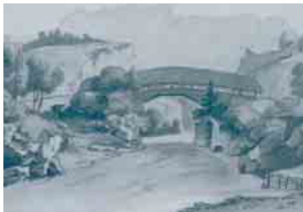
Abb. 67 Hölzerne Sprengwerkbrücke im unteren Teil des Kanderdurchstichs. Sie ersetzte die 1746 infolge Unterkolkung eingestürzte Steinbrücke aus der Bauzeit.
