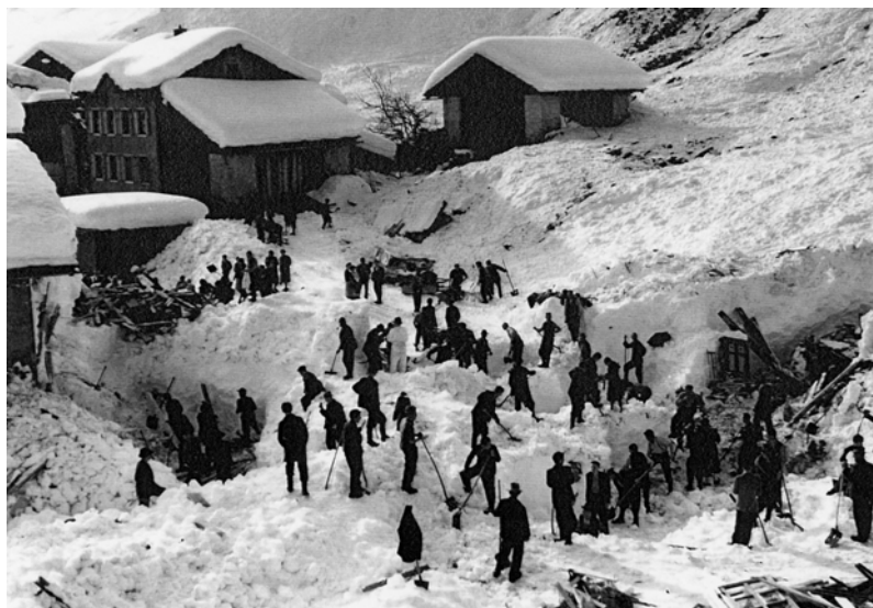
Such- und Aufräumungsmannschaften. Im Hintergrund Haus A. Reinle-Schmid.
