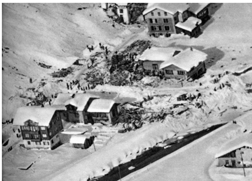
Sicht auf Hauptunglücksstätte mit den zerstörten Häusern Heinrich Tönz und Josef Anton Schnyder-Furger. Zur Orientierung: im Hintergrund Haus Baumeister Schnyder.
