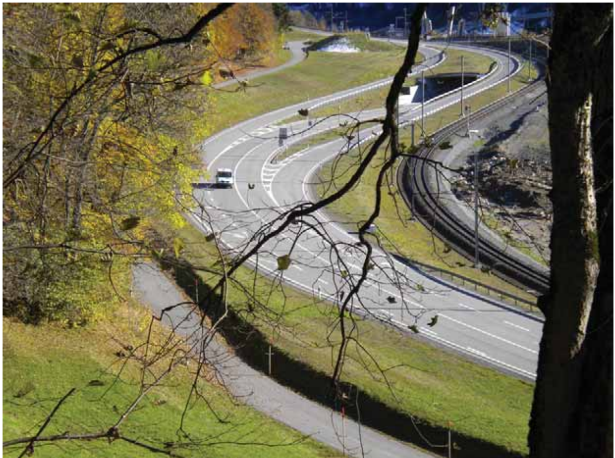
Abb. 2: Verkehr: Verzeigung National- und Kantonsstrasse sowie Trasse der RhB befinden sich unmittelbar unterhalb des Gruobenwalds.
