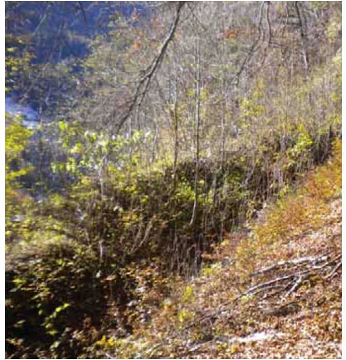
Abb. 5: Schuttdamm: Schuttdamm oberhalb Chus besitzt aufgrund der geringen Nutzhöhe und der bergseitigen flachen Böschung eine eingeschränkte Zuverlässigkeit.
