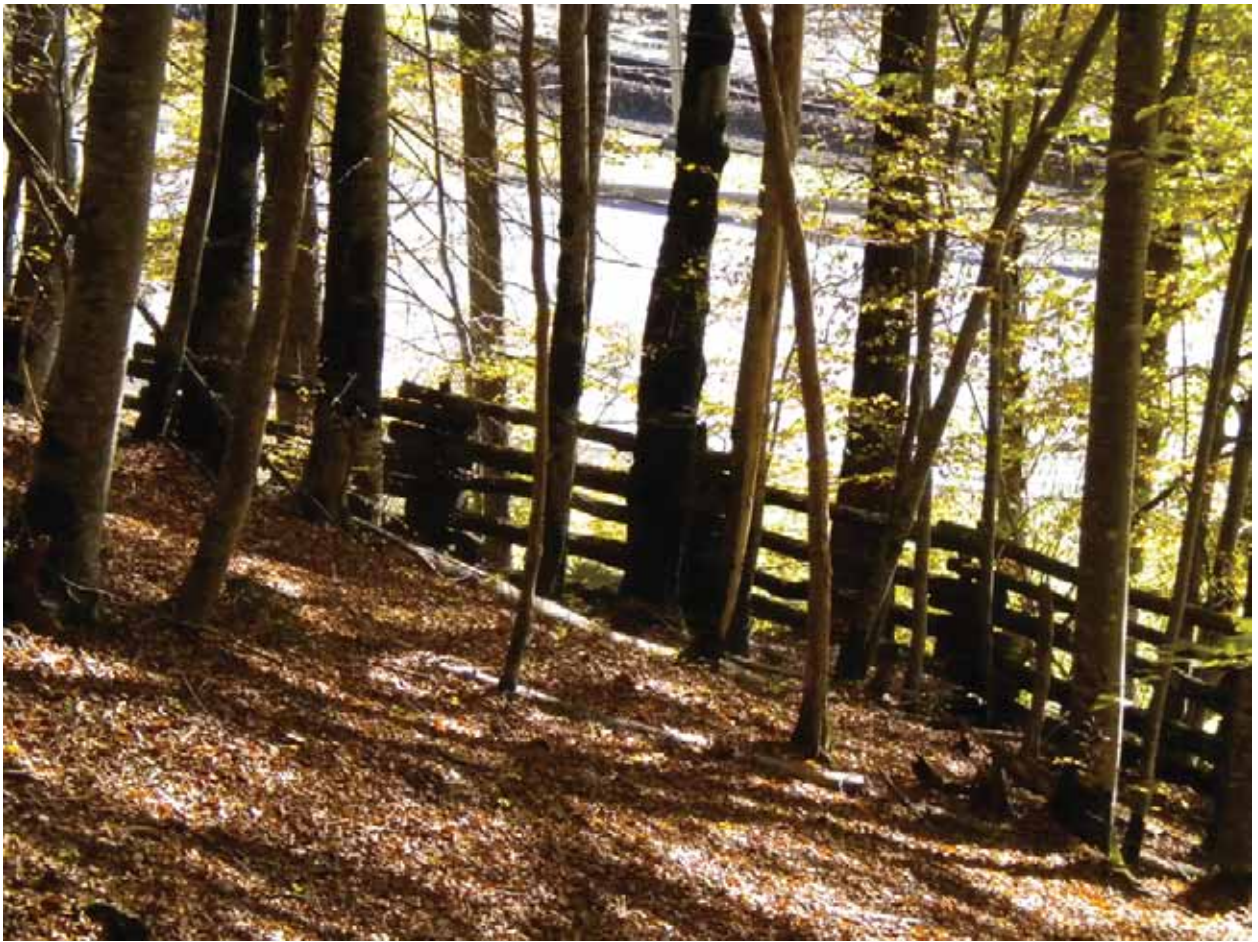
Abb. 6: Steinschlagschutzwand: Die Schutzwand bestehend aus Stahlprofilen mit Holzausfachung besitzt eine beschränkte Zuverlässigkeit. Sie hält Einwirkung bis ca. 50 kJ stand.
