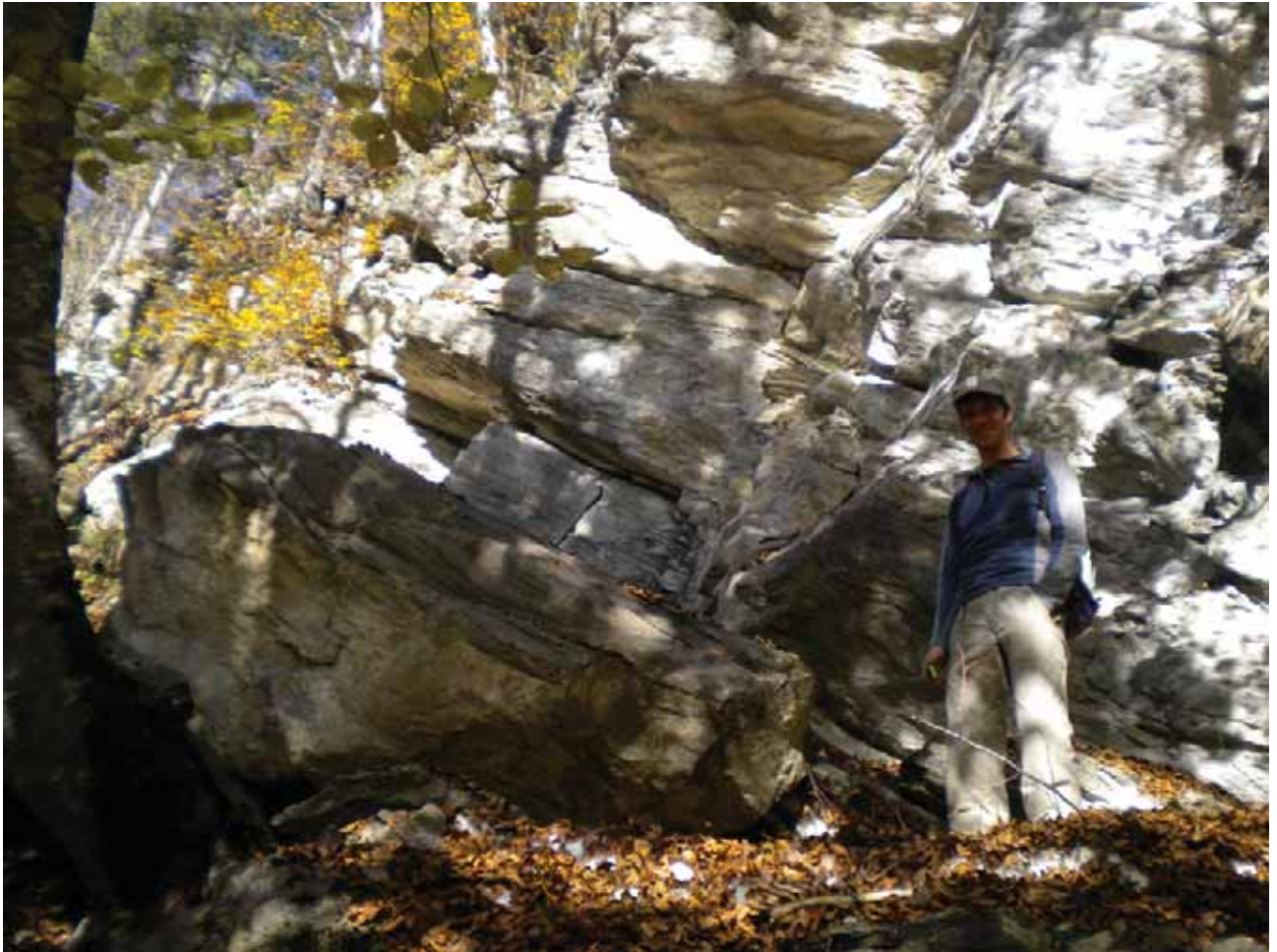
Abb. 3: Ausbruchsgelände: Unterschiedlich stark gebankte Kalke in Wechsellage mit zurückgewitterten Kalk- und Mergellagen verursachen eine hohe Steinschlagaktivität. Im Vordergrund massiger Sturzkörper, welcher unmittelbar unterhalb der Felswand abgelagert wurde.
