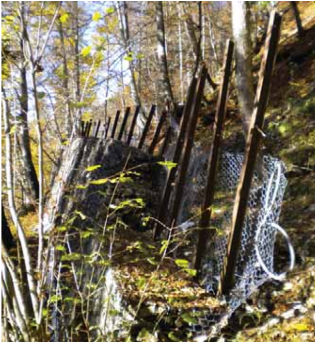
Abb. 4: Fallböden: Schutzverbauung bestehend aus Steinkorbmauer und „Schutznetz“ besitzt eine geringe Zuverlässigkeit.
