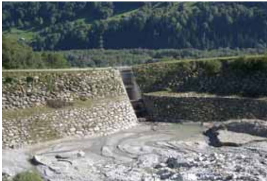
Abb. 4.7: Massiver Erddamm mit Blockwurf und durchgehender betonierter Abflusssektion (Trun, Kt. Graubünden).
