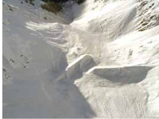
Abb. 3.4: Mit viel zu hoher Geschwindigkeit überflossene Auffangdämme. Praktisch kein Schnee wurde zurückgehalten.
