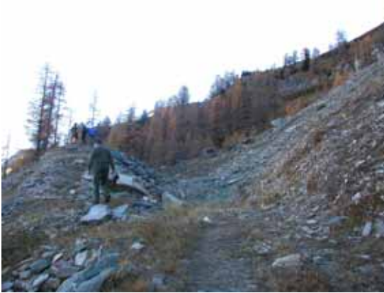
Abb. 3.3: Rund 5 m hoher Auffangdamm in einem Lawinenanrissgebiet. Wegen der geringen Höhe kann eine Lawine nicht gestoppt werden.
