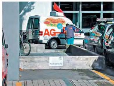
*Variante B: Abschottung der tiefer liegenden Lichtschachtöffnung durch seitliche Mauern, welche bis zur Rückstauenebene hochgezogen sind.*
