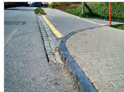
Rampenlösungen bei der Zufahrt zu tieferliegendem Terrain.
