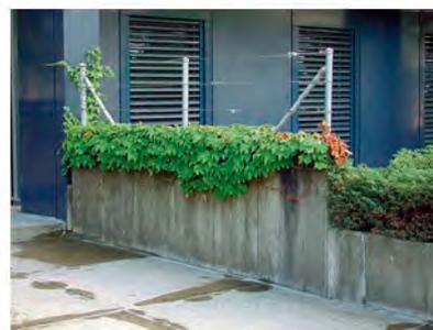
*Diese Rampe verhindert den Zufluss von Strassenwasser über den Treppenzugang.*
