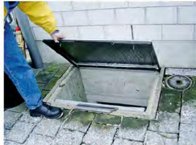
*Variante A: Lichtschacht mit abgedichtetem und verschraubbarem Deckel (Normalzustand: verschraubt).*
