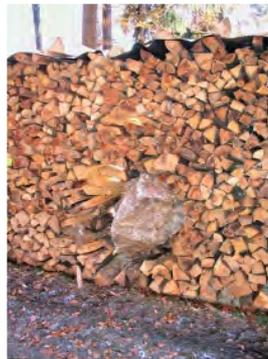
Bei geringen Sturzenergien kann eine Stückholzbeige die stossdämpfende Massnahme zum Schutz der Wände bilden.
