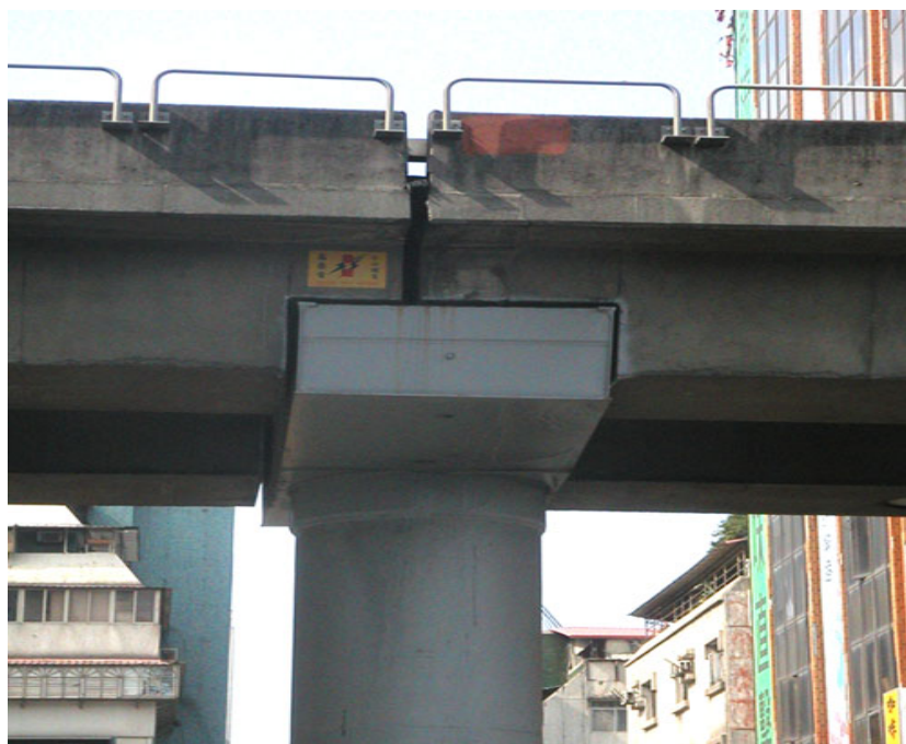
Bild 4.1: Zwischenfugen sind bei Strassenbrücken möglichst zu vermeiden
