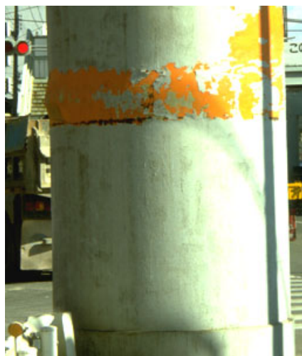
Bild 3.5: Beulen einer runden Stahlstütze beim Erdbeben von Kobe 1995
