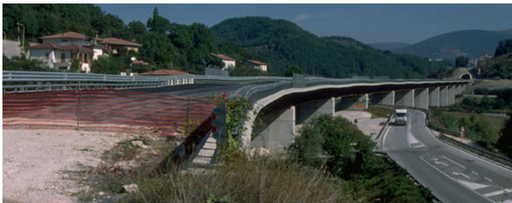
Bild 3.9: Balkenbrücke mit 657 m langem Durchlaufträger und fester Längslagerung beim Widerlager links im Bild (siehe Detail in Bild 3.10).
