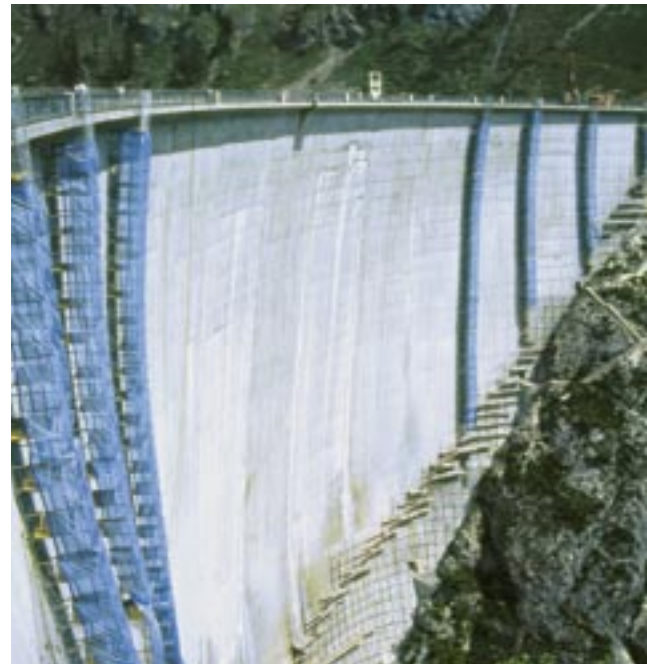
Die bauliche Sicherheit der Stauanlagen ist gewährleistet: Unterhalt des Speicherbeckens Airolo TI (links) und Sanierung der Staumauer Zeuzier VS (rechts) nach den Rissbildungen durch den Bau eines Sondierstollens.
