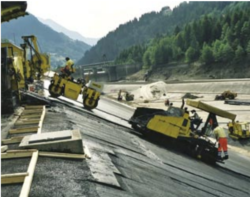
Die bauliche Sicherheit der Stauanlagen ist gewährleistet: Unterhalt des Speicherbeckens Airolo TI (links) und Sanierung der Staumauer Zeuzier VS (rechts) nach den Rissbildungen durch den Bau eines Sondierstollens.
