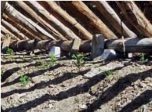
Temporäre Lawinerverbauungen aus Holz schützen etwa 30 Jahre lang vor Lawinen, dann verrottet das Holz. Foto: Corsin Flepp
