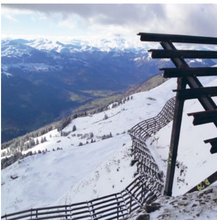
Lawinerverbauung Galmun, Saas (Foto: tur gmbh)
