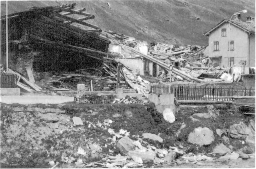
Fig. 8 VALS: Neben diesem Stall (erbaut 1777) wurde ein 200jähriges Wohnhaus zerstört. Sämtliche Bewohner dieser Häusergruppe waren durch die Gemeindebehörde vorher evakuiert worden.
