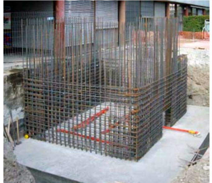
Bewehrung im Untergeschoss und Fundament des neuen Treppenturms.
