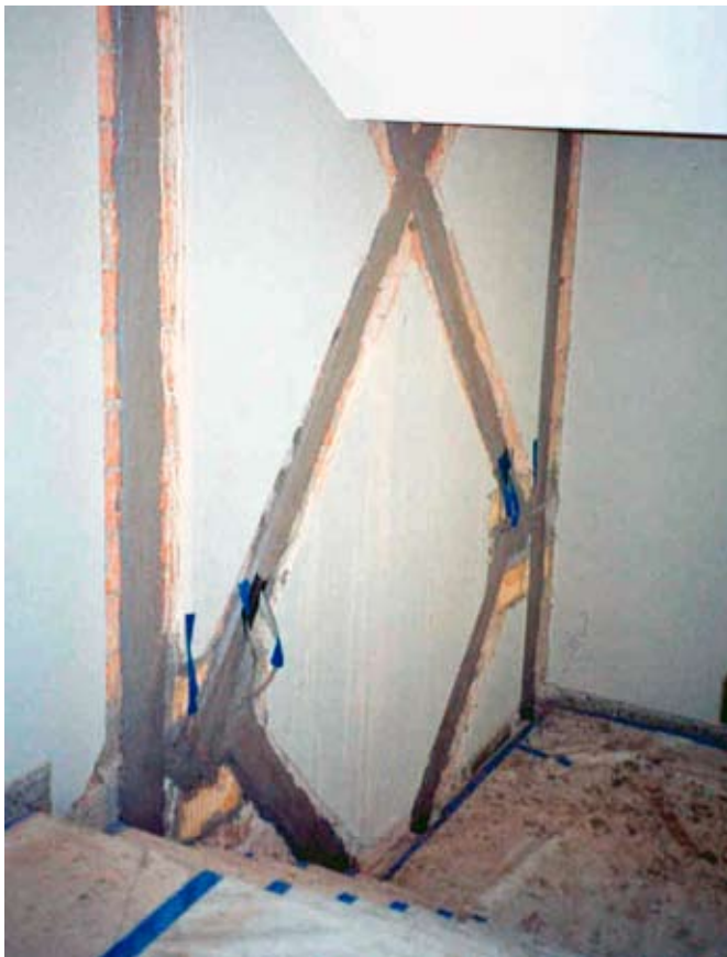
Verstärkung der Mauerwerkswände im Treppenhaus mit Kohlefaserlamellen.
