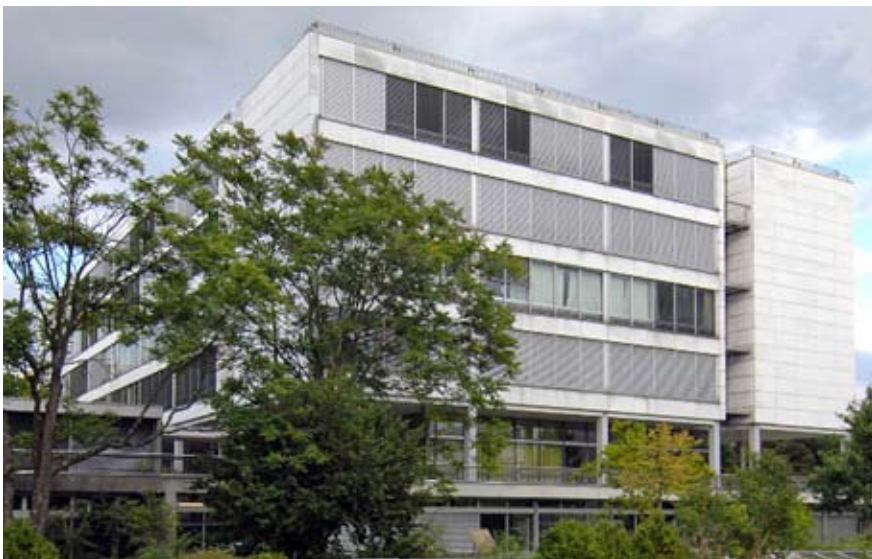
Ansicht an die Stirnfassade des Gebäudes.
