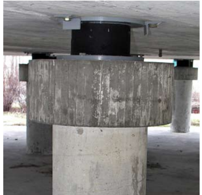
Nachträglich eingebautes Gummilager unter dem Flüssiggastank.
