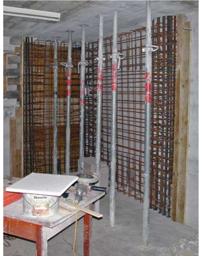
Bewehrung einer neuen Stahlbetontragwand im Untergeschoss.
