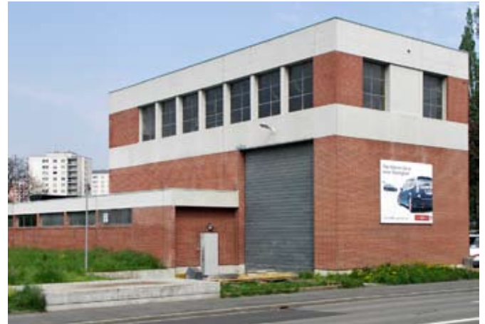
Aussenansicht der Montagehalle.
