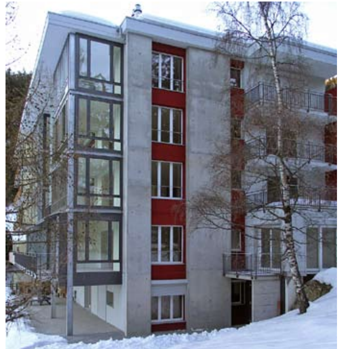
Ansicht an die Ostfassade mit den neuen Stahlbetontragwänden.
