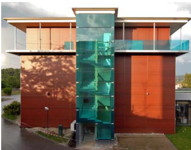
Stirnfassade auf der Nordseite mit neuem Treppenhaus aus Stahlbeton.
