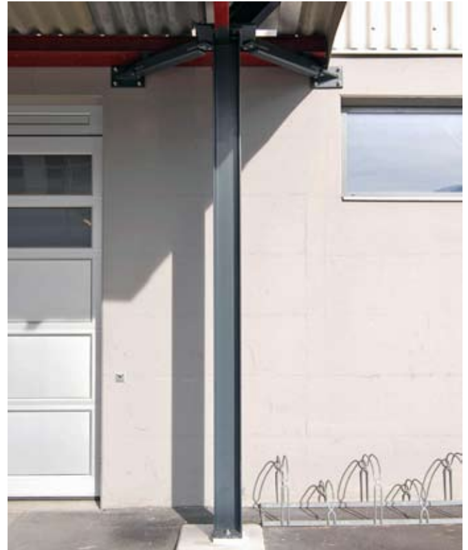
Randstütze der fischbauchförmigen Verstärkung im unteren Geschoss.
