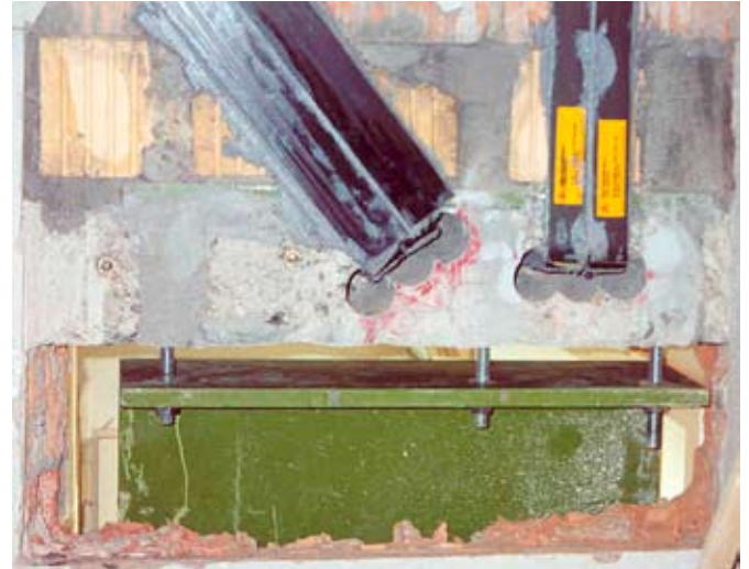
Verankerung der Kohlefaserlamellen mit Schubwinkeln in der Betondecke.
