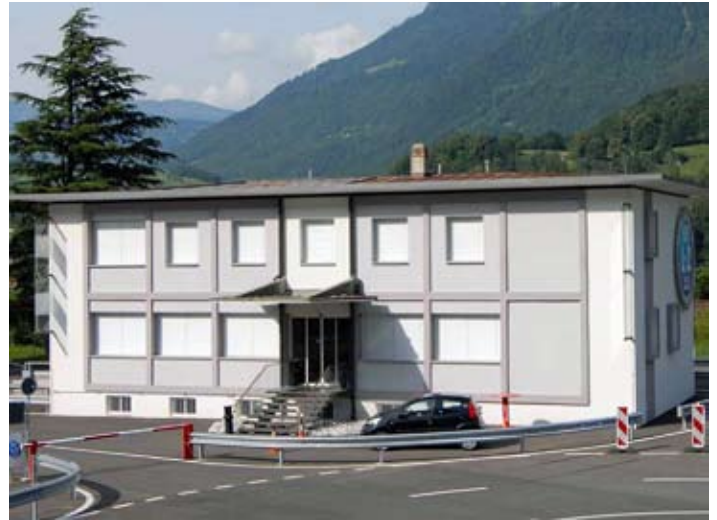
Ansicht an die vordere Längsfassade mit der neuen Stahlbetontragwand am äussersten Rasterfeld rechts.
