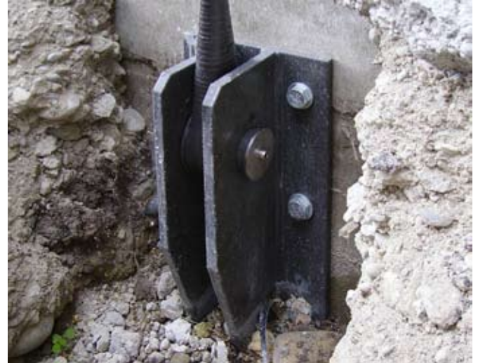
Untere Verankerung der CFK-Spannglieder seitlich in der Kellerwand.
