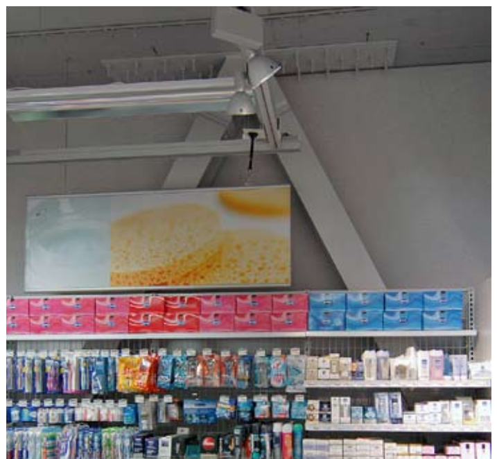
Neues V-förmiges Stahlfachwerk versteckt hinter einem Verkaufsregal im Erdgeschoss.
