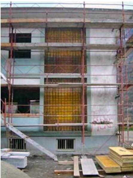
Bewehrung der neuen Stahlbetontragwand in der vorderen Längsfassade.
