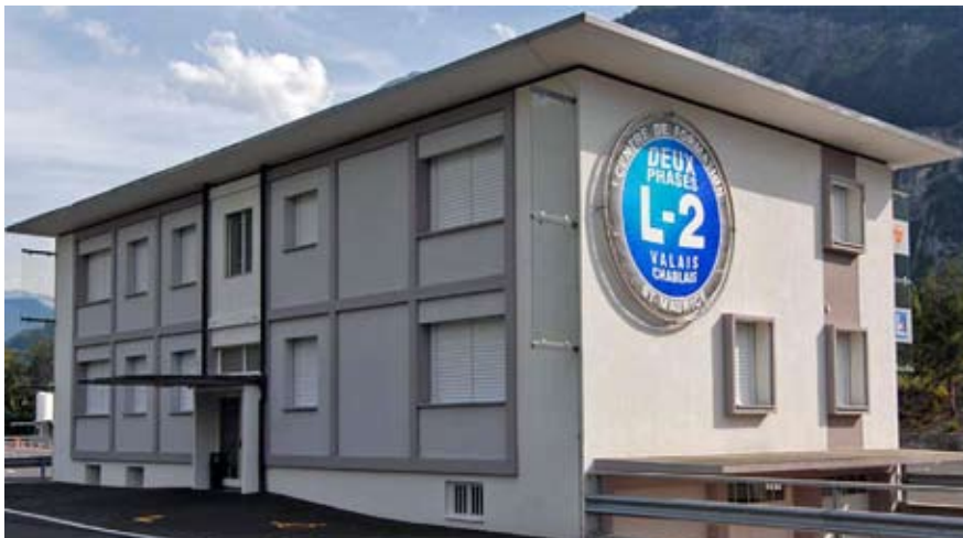
Ansicht an die hintere Längsfassade mit der neuen Stahlbetontragwand im mittleren Rasterfeld rechts.
