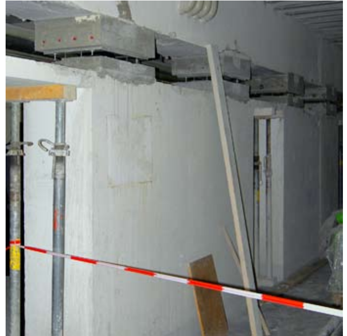
Unter dem stützenfreien Innenbereich werden Gleitlager eingebaut.
