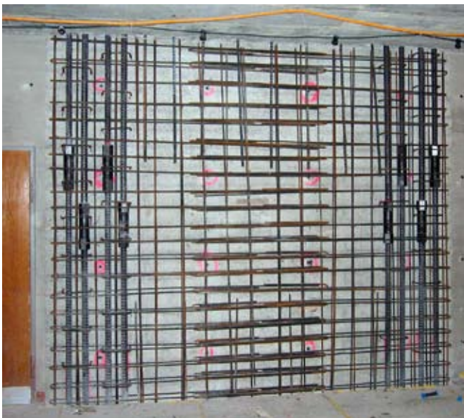
Bewehrung einer Aufdoppelung mit den vertikalen Bewehrungsstössen.
