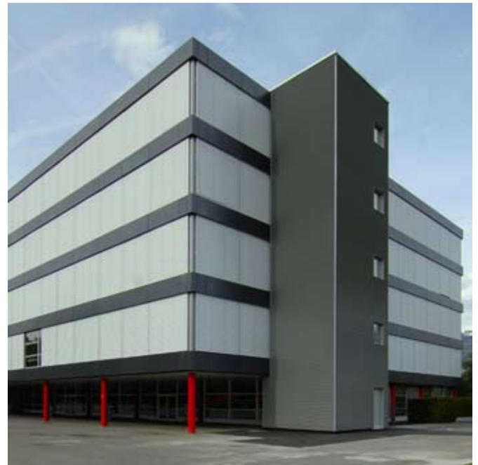
Ansicht an den neuen Treppenturm auf der Südseite.
