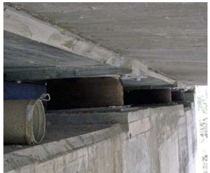
Ertüchtigung mit Erdbebenlagern aus hochdämpfenden Gummischichten beim Widerlager.
