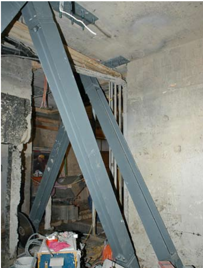
Einbau der neuen V-förmigen Stahlfachwerke im Erdgeschoss.
