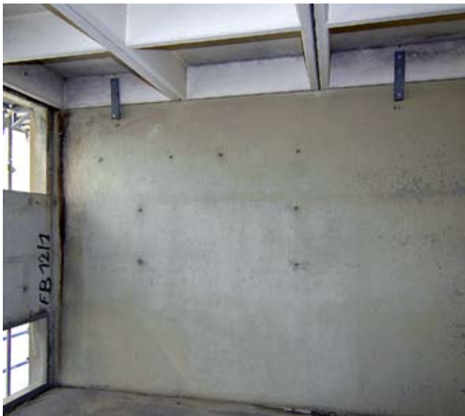
Nachträglich eingebaute Stahllaschen zur Verbindung der Kassettendecke mit den Wänden.
