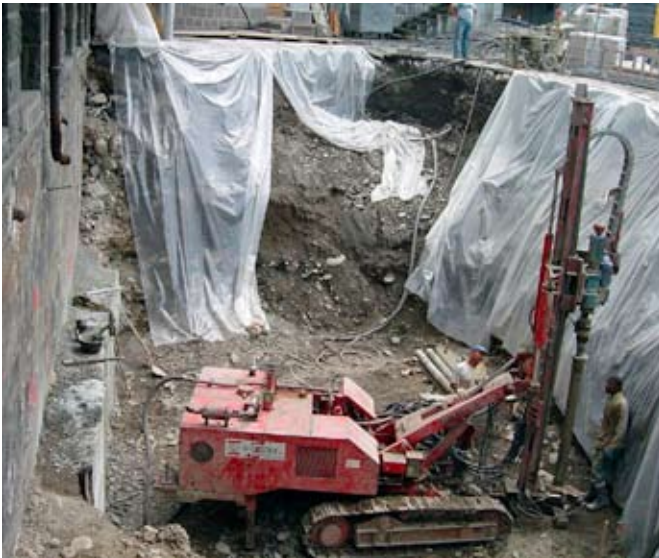
Bau der Foundation des neuen Stahlbetonliftkerns mit Mikropfählen.
