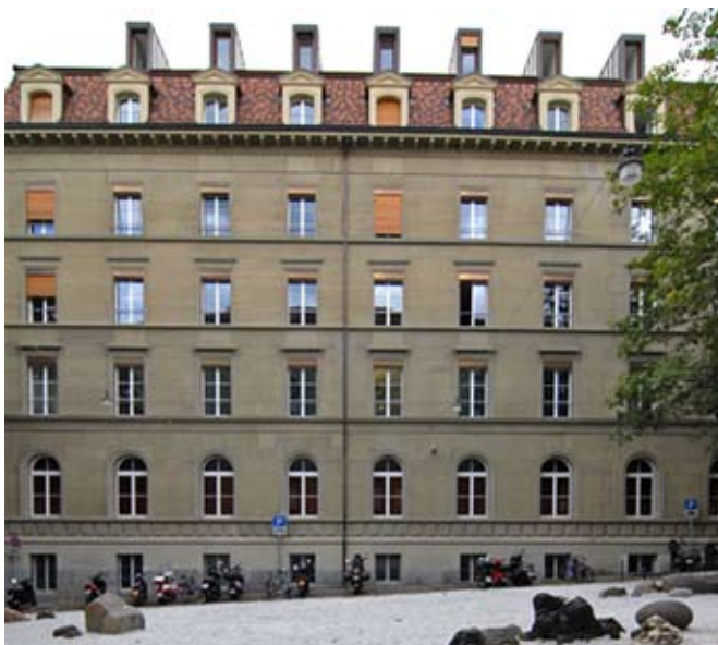
Ansicht an die östliche Seitenfassade.
