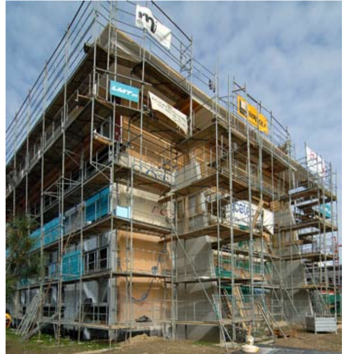
Die beiden neuen dreieckförmigen Stahlbetonwände auf der Südseite im Bauzustand.
