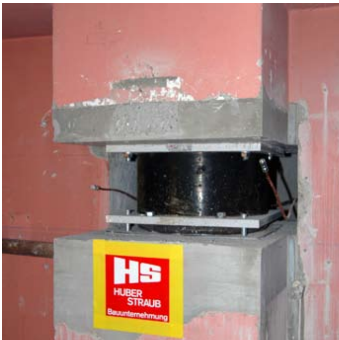
Einbau eines Erdbeben-Gummilagers unter einer Stütze in der Aussenwand des Untergeschosses.
