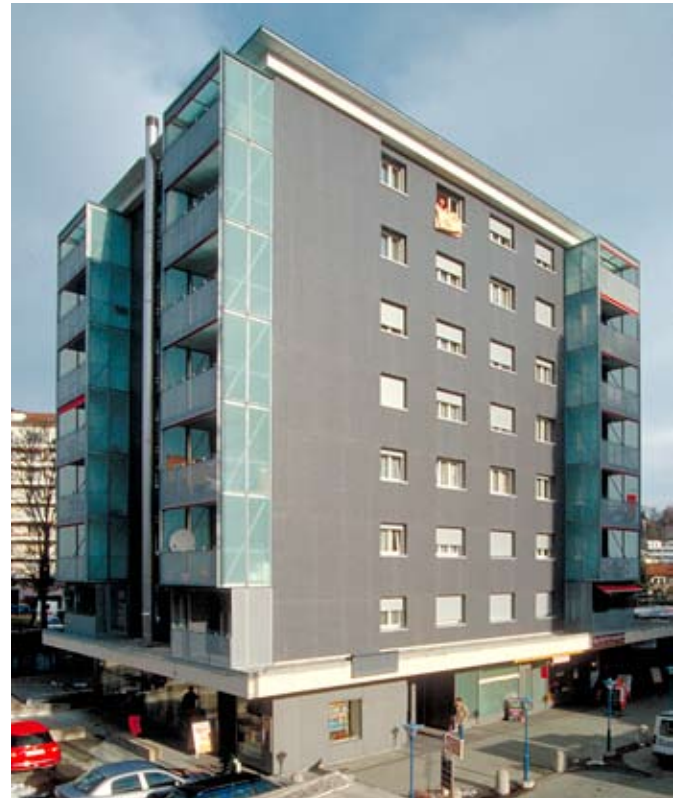
Ansicht an die neue aussenliegende Stahlbetontragwand.
