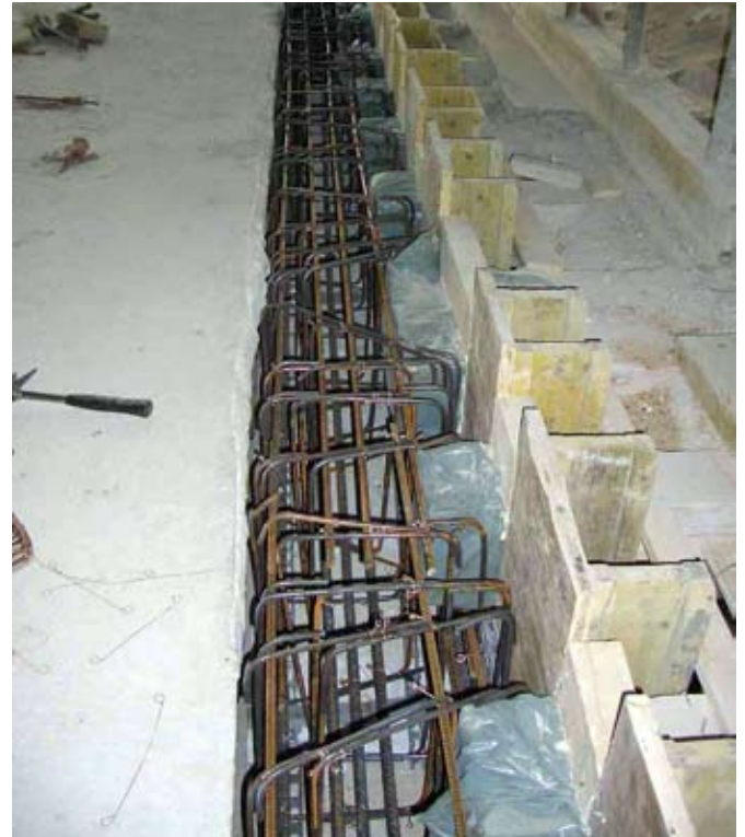
Verankerungsbewehrung der neuen Decken in den Mauerwerks-wänden.
