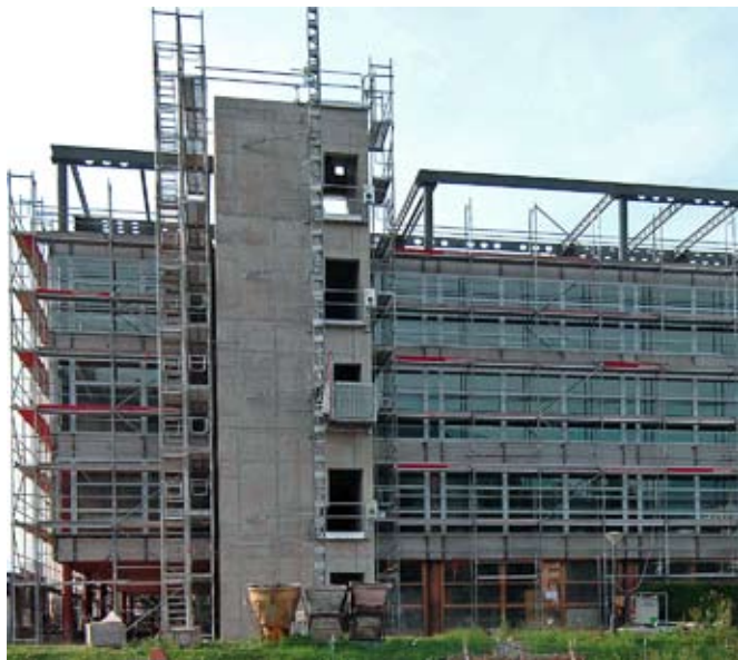
Treppenturm und Aufstockung im Bau (Südseite).
