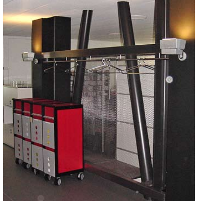
Neues exzentrisches Stahlfachwerk mit Stützenverkleidung.
