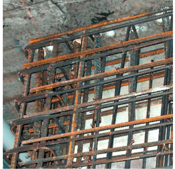
Anschlussbewehrung der neuen Stahlbetonwände in die bestehenden Decken (Garcia-Vogel 2005).
