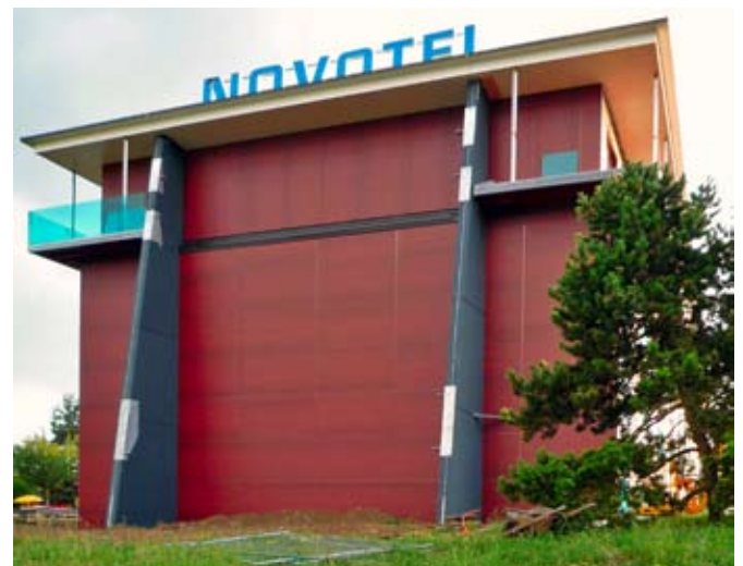
Stirnfassade auf der Südseite mit den beiden neuen dreieckförmigen Stahlbetonwänden.
