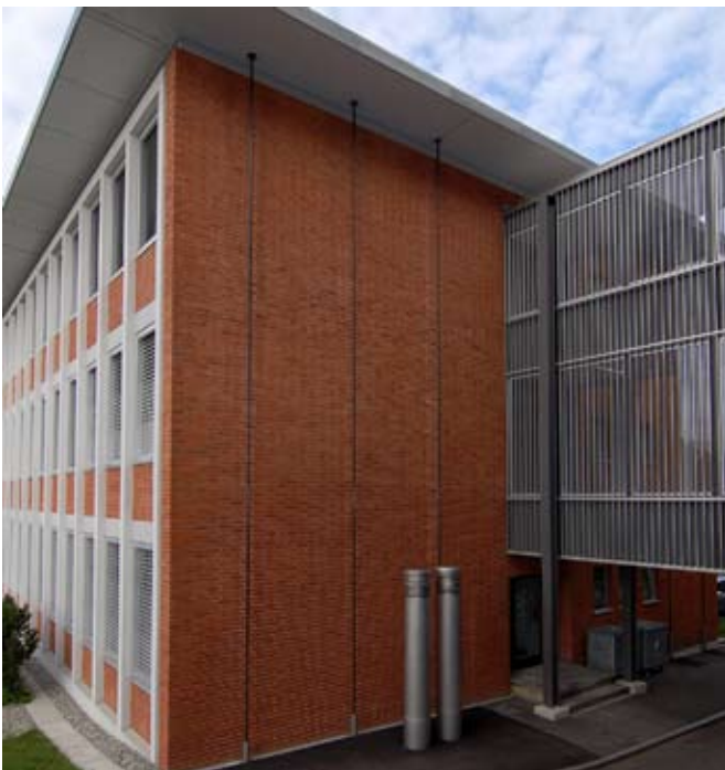
Nördliche Stirnfassade verstärkt durch externe vertikale CFK-Spannglieder.
