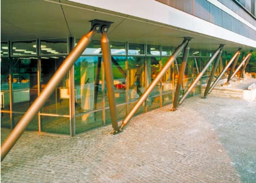
Neues geneigtes Stahlrohrfachwerk im Erdgeschoss.
