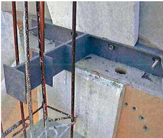
T-förmiges Stahlteil zur Verankerung der neuen Stahlbetonwände in den bestehenden Decken.
