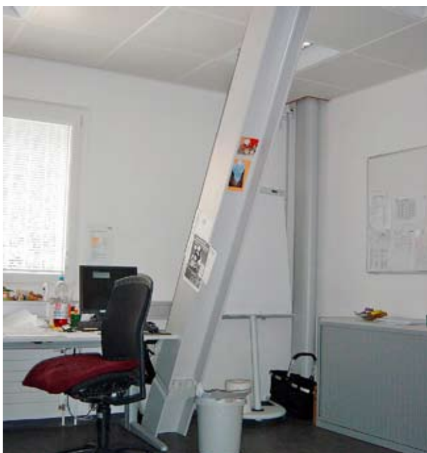
Neues V-förmiges Stahlfachwerk in einem Büroraum des Erdgeschosses.
