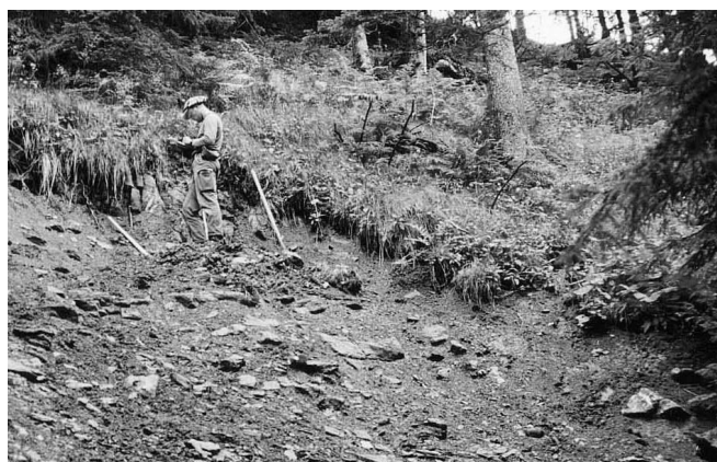
Abbildung 3: Arbeiten bei den Rutschflächen.
