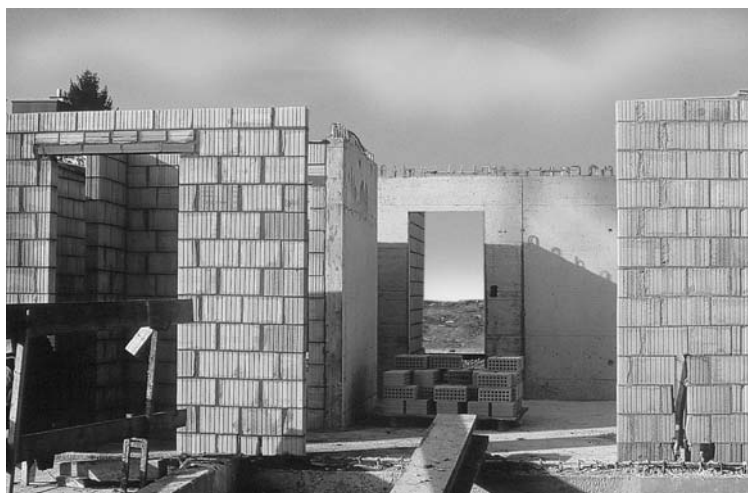
Bild 2: Durch Stahlbetonwände ausgesteifter Mauerwerksbau
