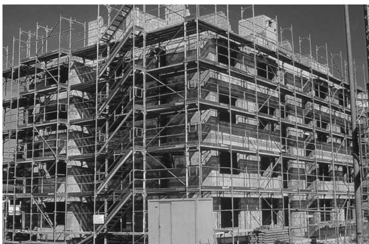
Bild 2: Mauerwerksbau mit problematischem Erdbebennachweis
