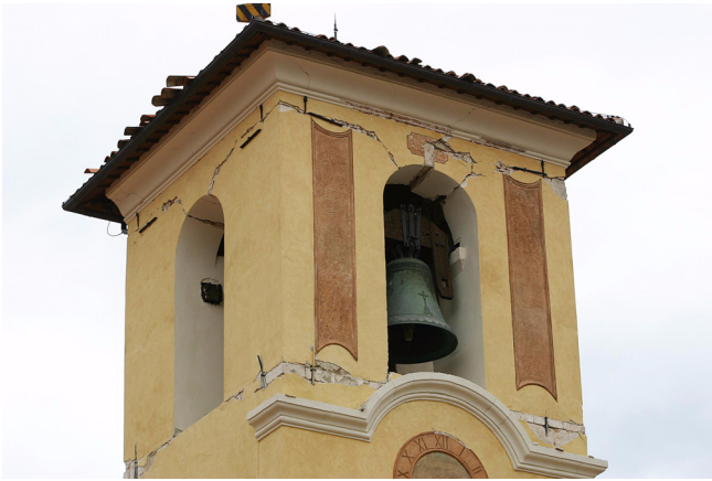
Abb. 13: Glockenturm mit Zugstangen.
