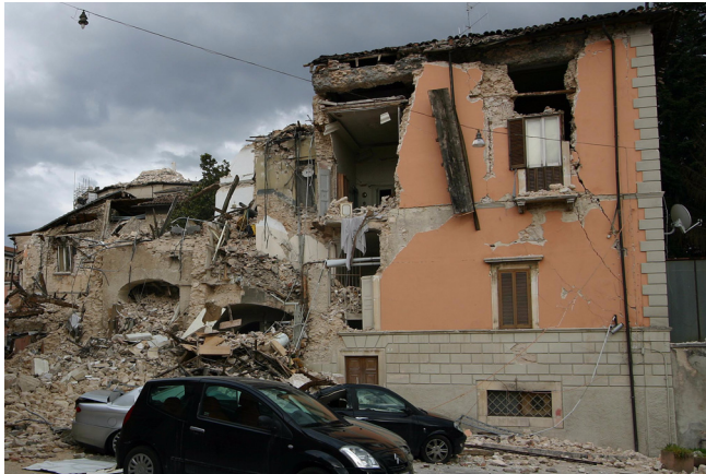
Abb. 17: Gebäude im Stadtzentrum von L'Aquila bei dem trotz Ringbalken Versagen aufgetreten ist.
