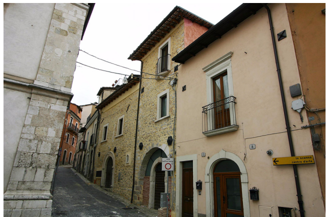
Abb. 12: Saniertes Bruchsteinmauerwerksgebäude im Stadtzentrum von L'Aquila.
