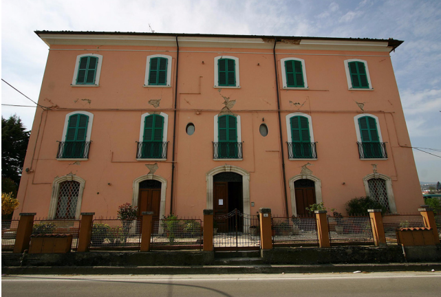
Abb. 21: Gebäude aus altem Ziegelsteinmauerwerk in L'Aquila.
