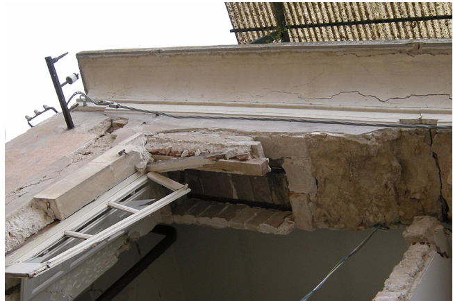
Abb. 11: Gebäude in Abb. 10: Zugbänder innerhalb von Ziegelementen auf Höhe der zweiten Geschossdecke
