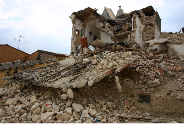
Abb. 6: SLC-Deckensystem in einem eingestürzten Bruchsteinmauerwerksgebäude in Onna.
