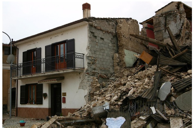
Abb. 25: Wohngebäude in Onna aus Betonsteinmauerwerk.
