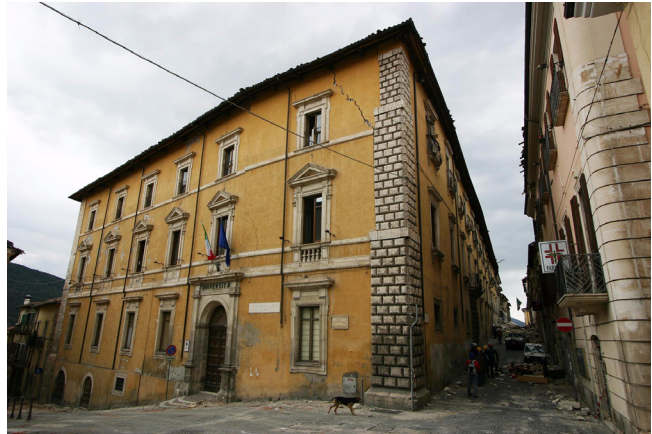
Abb. 4: Palast aus Bruchsteinmauerwerk mit Eckpfeilern aus behauenen Steinen im Stadtzentrum von L'Aquila.
