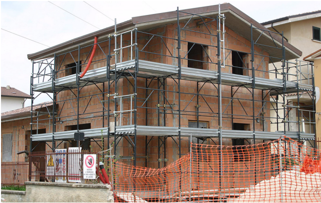
Abb. 26: Sich noch im Bau befindendes modernes Mauerwerksgebäude mit Stahlbetonelementen in L'Aquila.
