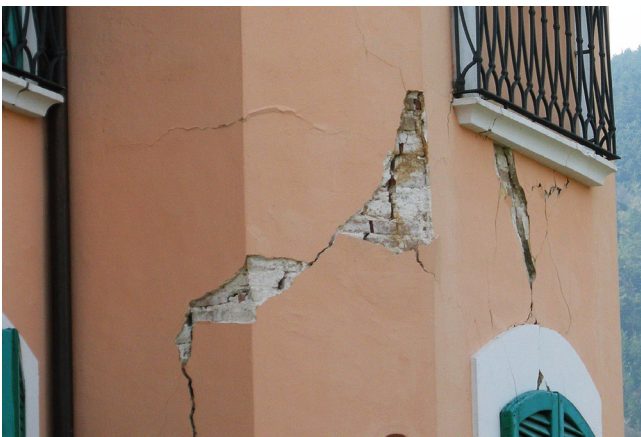
Abb. 22: Nahaufnahme des Mauerwerks.
