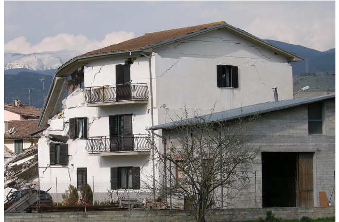
Abb. 23: Wohngebäude in Onna aus Betonsteinmauerwerk.
