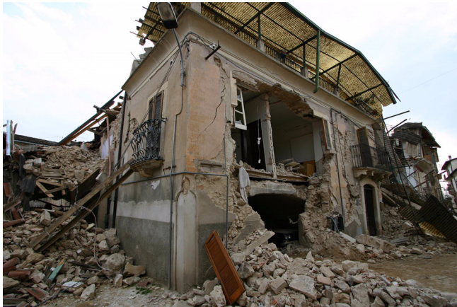
Abb. 10: Gebäude in Onna aus Bruchsteinmauerwerk mit Holzbalkendecke und Zugelementen aus Stahl.
