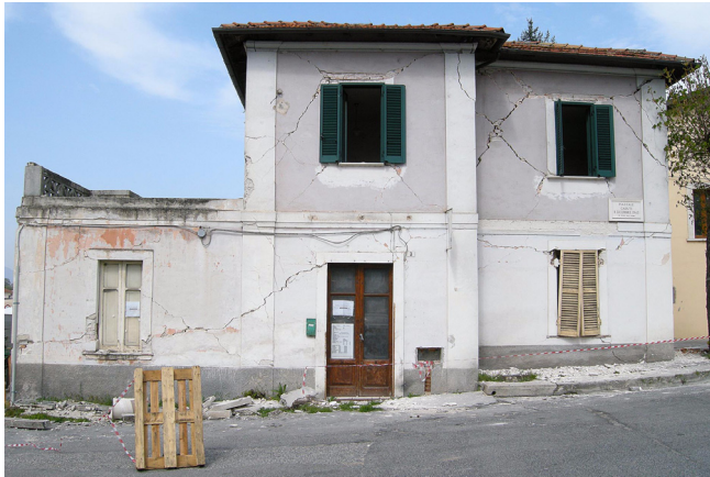
Abb. 3: Gebäude aus Bruchsteinmauerwerk am Bahnhofplatz in L'Aquila.
