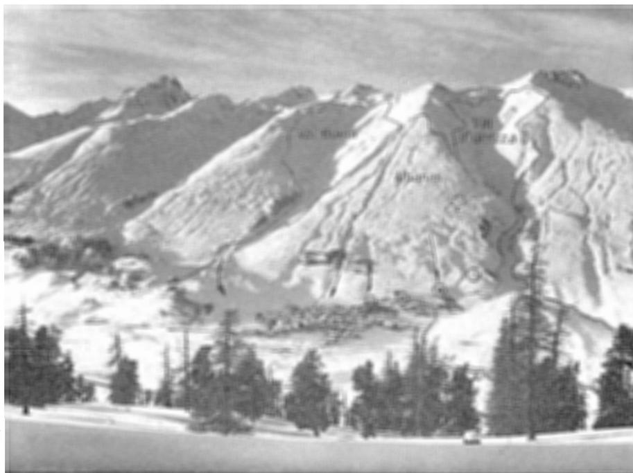
Fig. 61 Die Lawine von Zuoz. Rechts Einzugsgebiet, Sturzbahn und Ablagerungszone der Val d'Urezza- und Albanas-Lawinen. Einkreist die zerstörten Gebäude.
