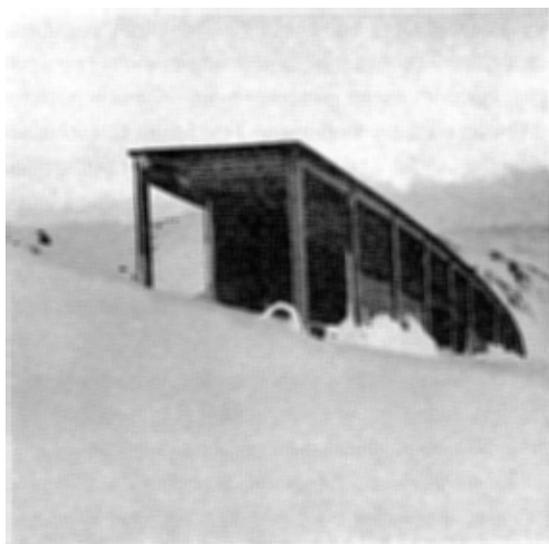
Fig. 107 Sogwirkung einer Lawine an einer Galerie der Davos-Parasennbahn. Die Lawine floß (in Aufnahmerichtung) am oberen Ende der Galerie vorbei.
